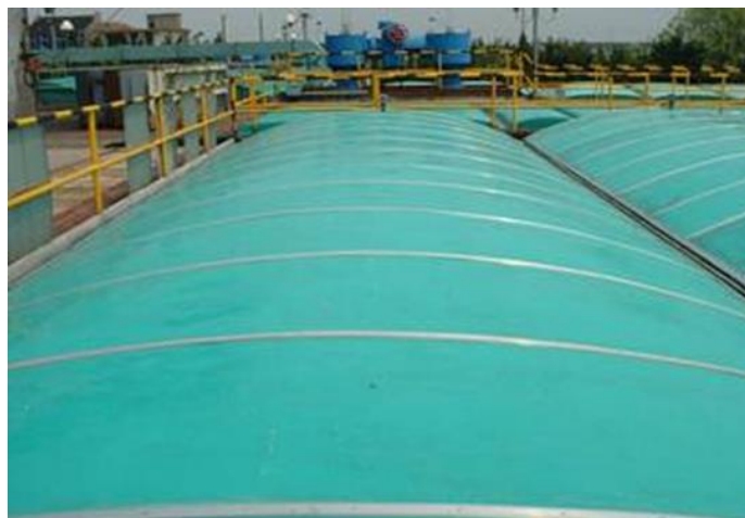
图 8.2.1-3 钢支承反吊氟碳纤膜结构图例
