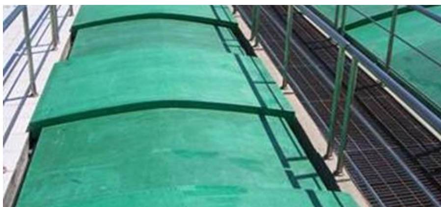
图 8.2.1-5 聚酯玻璃钢加盖工程实例图
