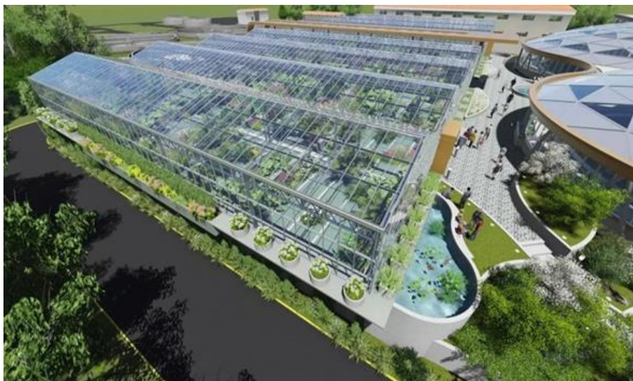
图 8.2.1-7 热镀锌钢骨架玻璃/耐力板阳光棚
