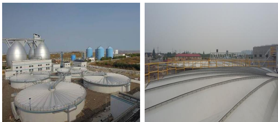
图 8.2.1-6 高强度曲面拱形玻璃钢加盖工程实例图
