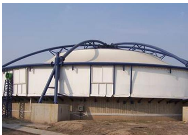
图 8.2.1-4 钢支承反吊氟碳纤膜结构图例
