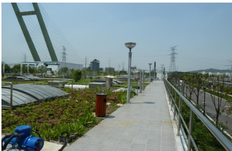
图 8.2.1-1 钢筋混凝土加盖池顶绿化封闭
