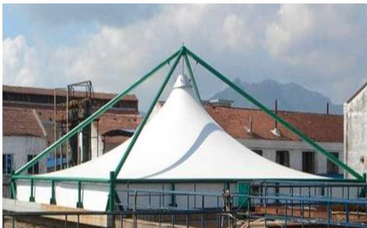
图 8.2.1-2 钢支承反吊氟碳纤膜结构图例
