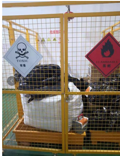
图 1-3 现有车间危废暂存区照片
