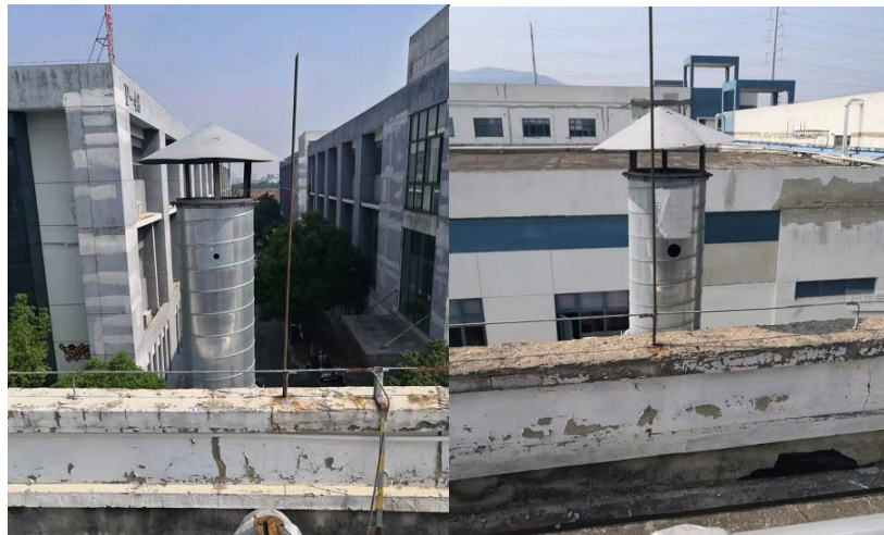
图 1-2 现有 1#、2#排气筒照片
