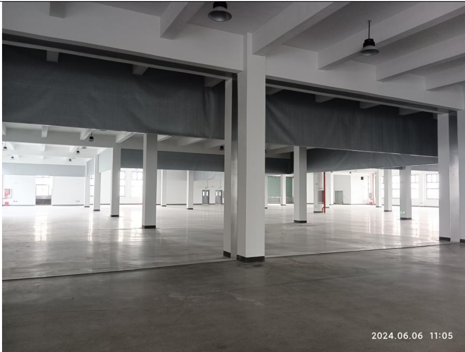
3 楼西侧闲置厂房
