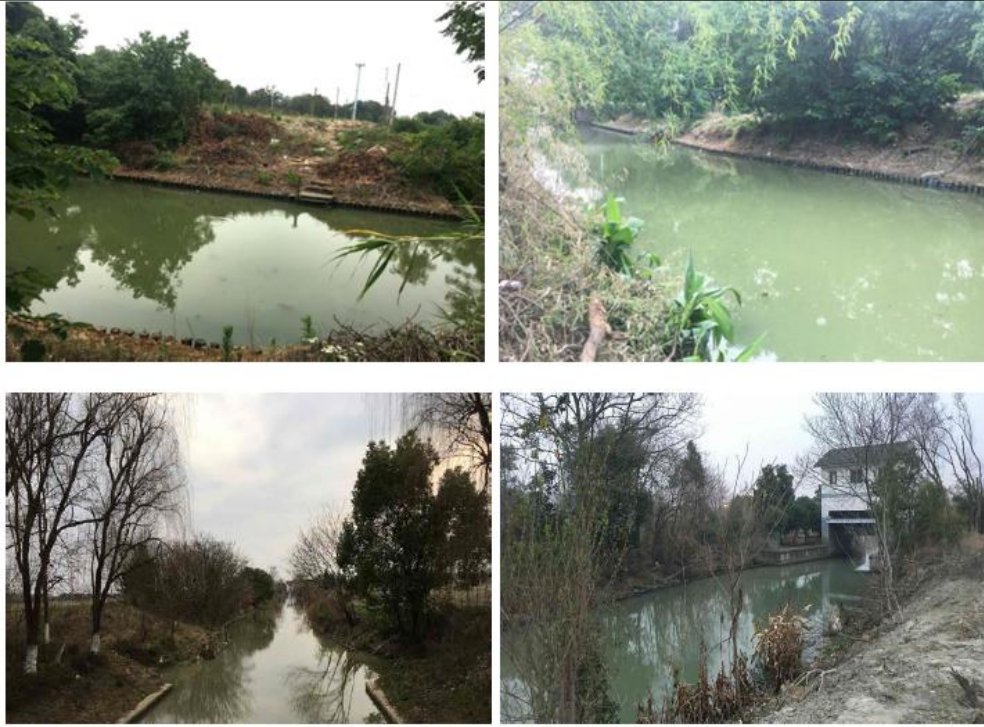
图 3-3 九曲港河道现状
