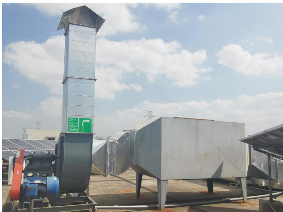
图3.2 项目废气排口
