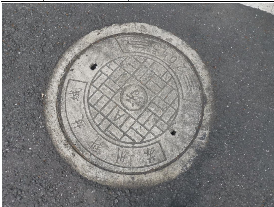
图3.1 项目污水总排口
