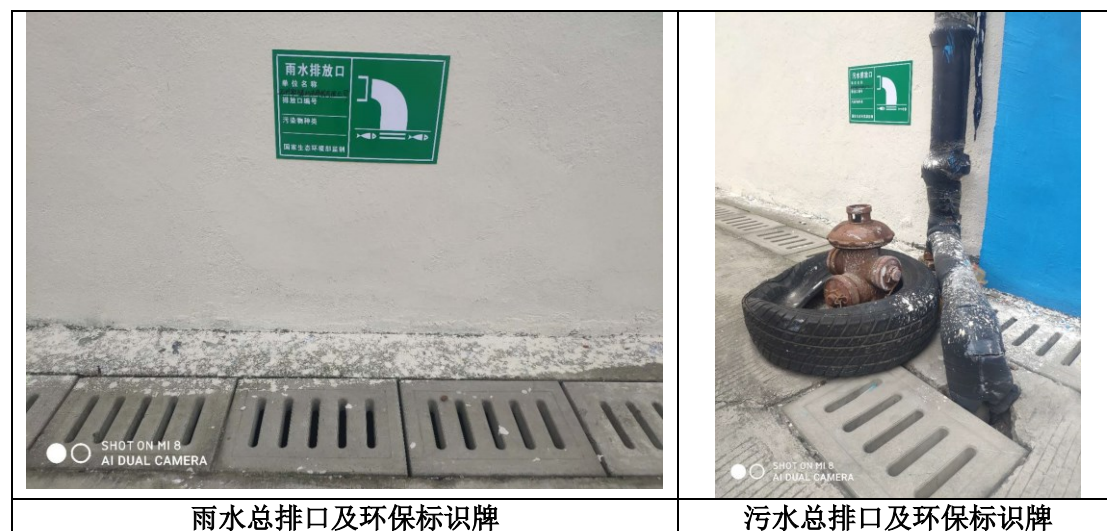
图 3-1 雨污水总排口及环保标识牌
