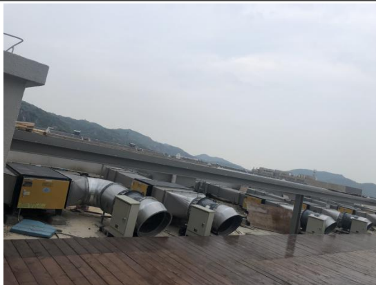
屋顶装配的油烟净化器
