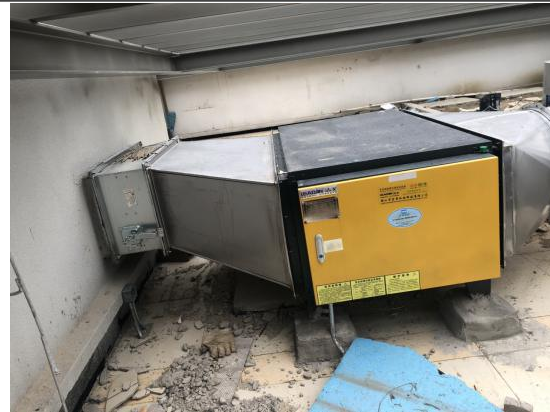
屋顶装配的油烟净化器
