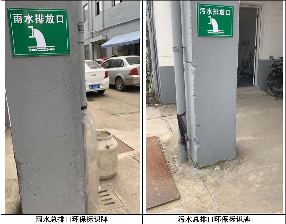
图 3-1 雨污水总排口及环保标识牌
