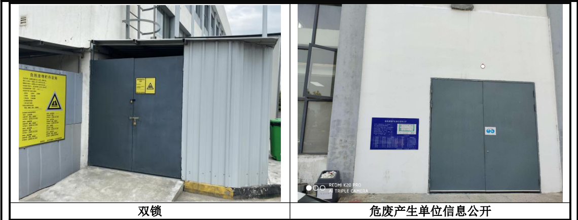
图 3-8 危险废物暂存仓库建设现状
