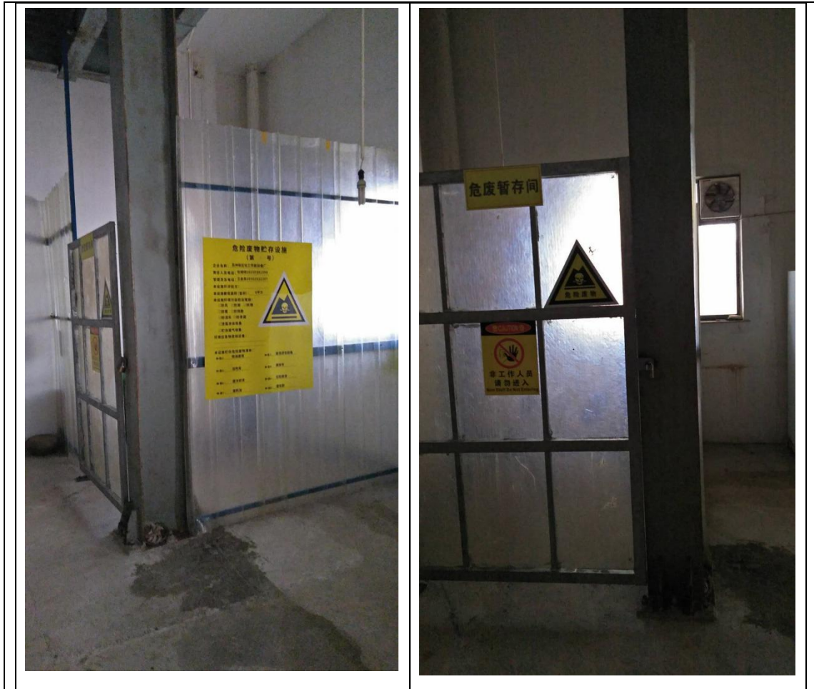
图 3-3 危废仓库现场照片
