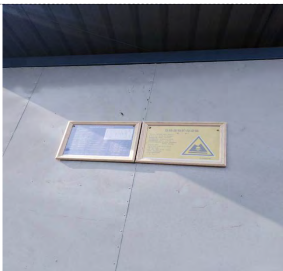
危废库门口标牌
