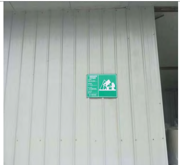
一般固废暂存处
