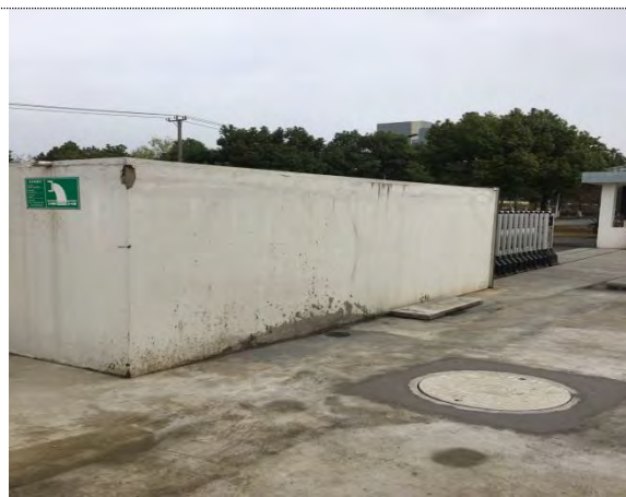
厂区废水总排口
