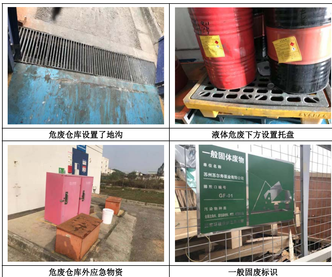
图 4.1-11 固废仓库建设现状
