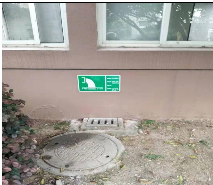
图 3-3 废水排口照片
