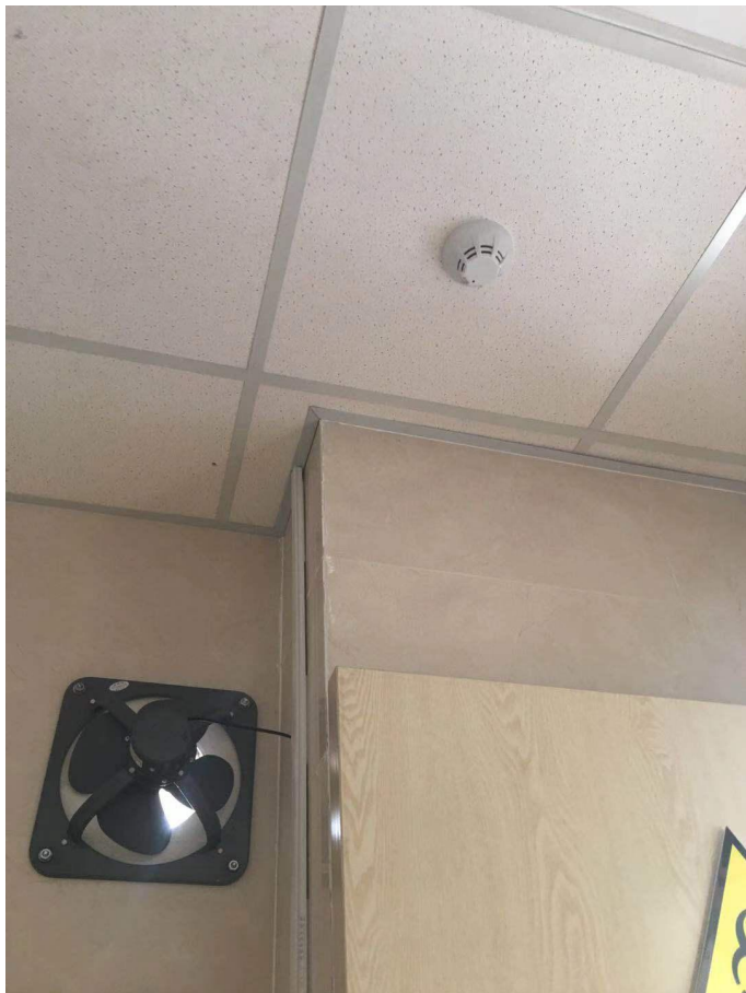
图3 危废暂存场所排风扇照片
