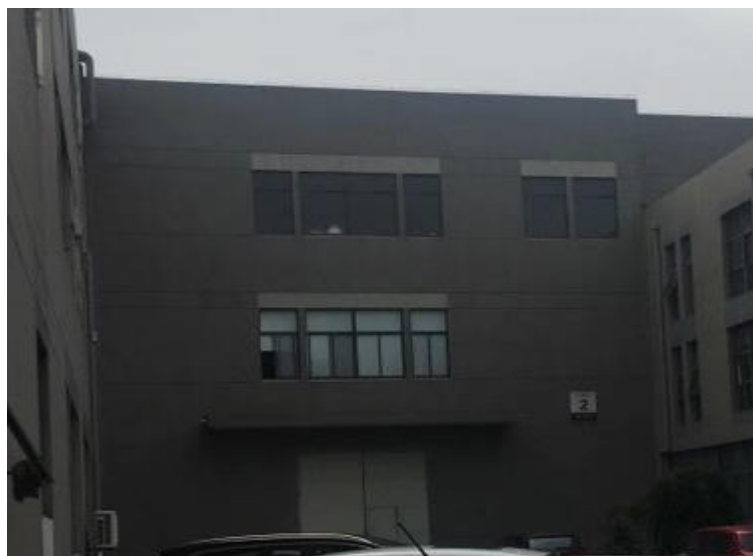
图 4-1 2#厂房（原环评中加建车间）现场照片
