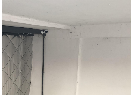
图 3-12 危废仓库内部监控照片
