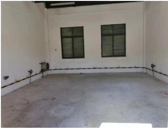
图 3-9 危废仓库内部照片
