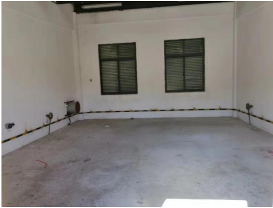
图 3-3 危废仓库内部照片
