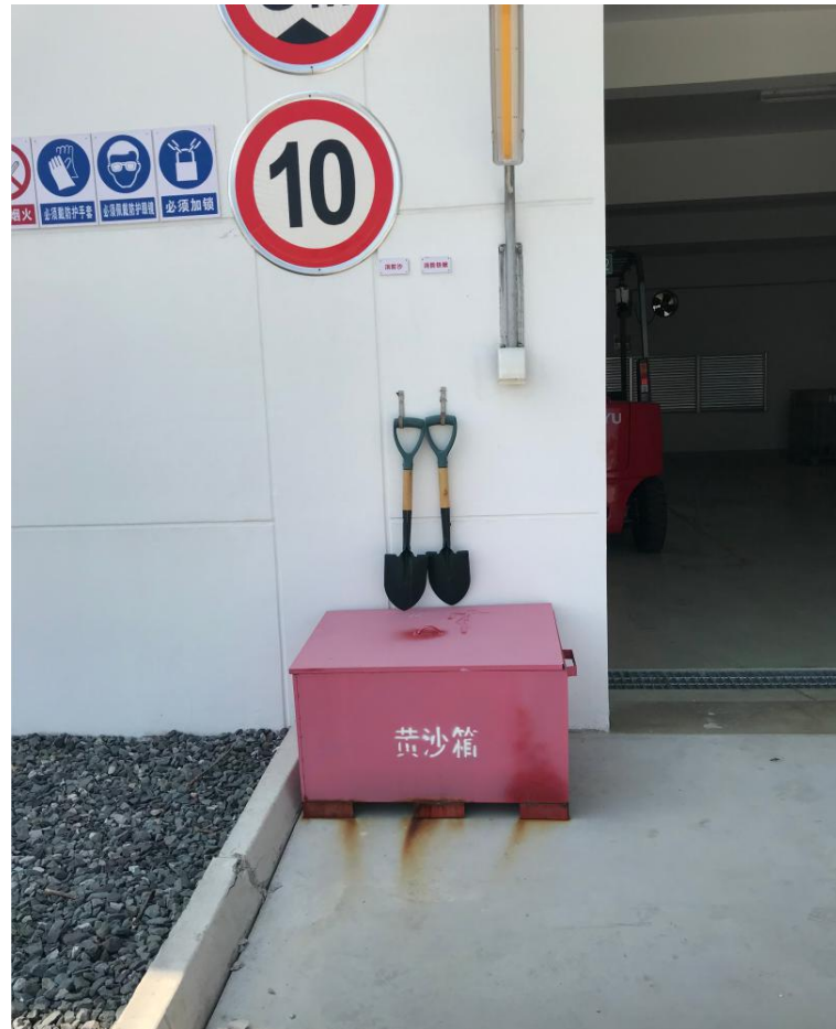
危废仓库门口放置了黄沙箱
