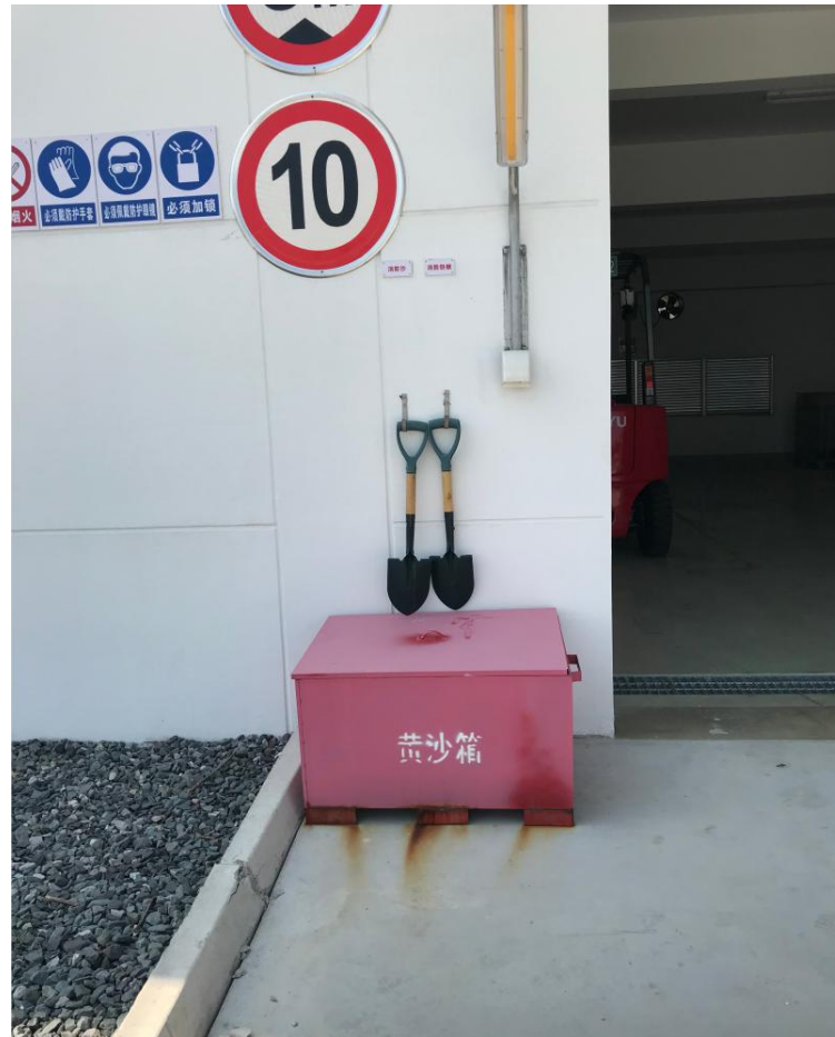
危废仓库门口放置了黄沙箱
