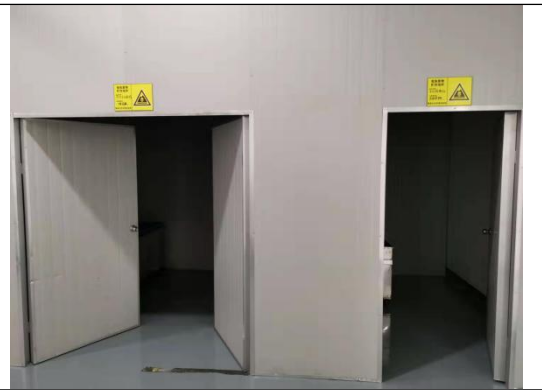
本图 3-5 危废暂存区
