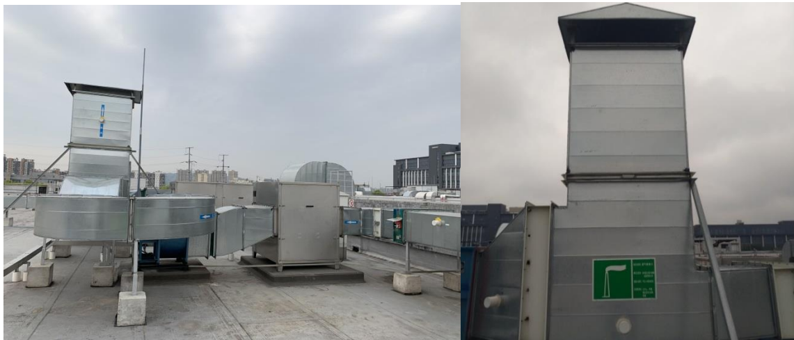
图3-3 废气处理设施及标志牌示意图
