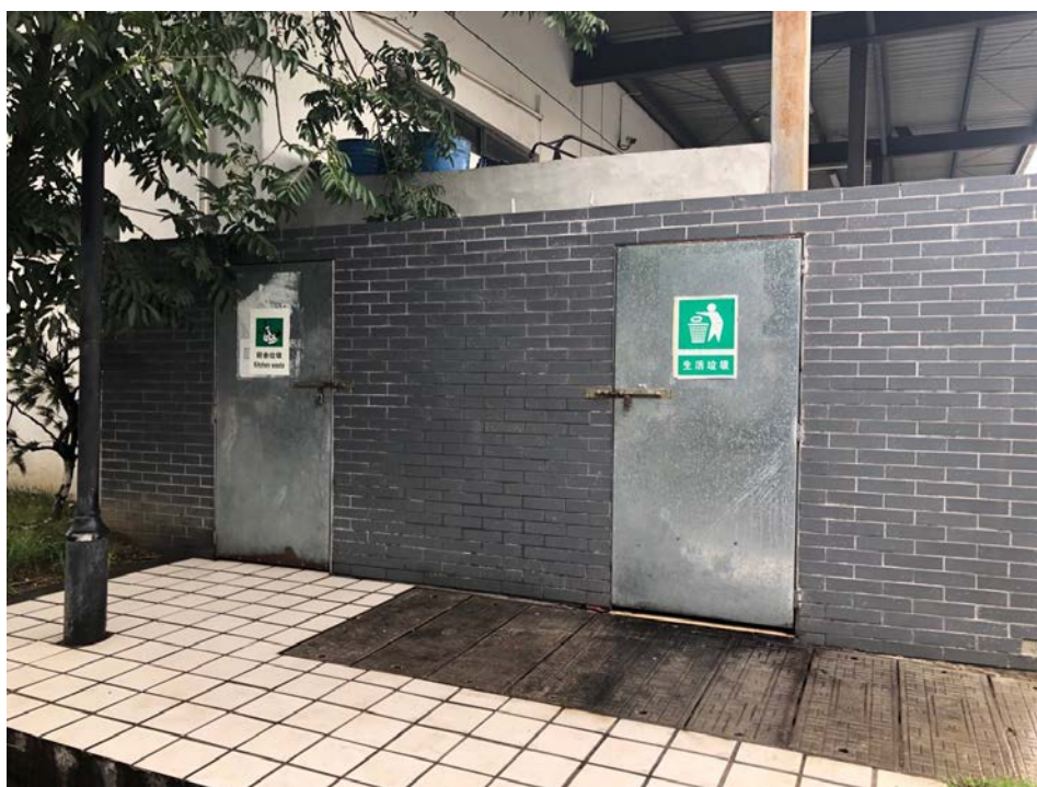
图 3-3 厨余垃圾和生活垃圾暂存区照片（各为 2.5 平方米）
