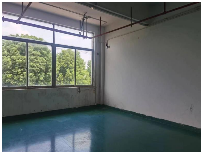
新增 20 平方米危险废物仓库
