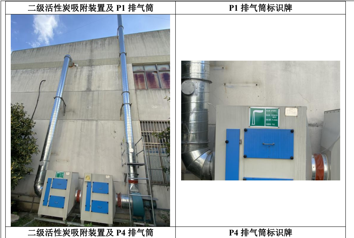
图 3-2 废气处理设施及排气筒
