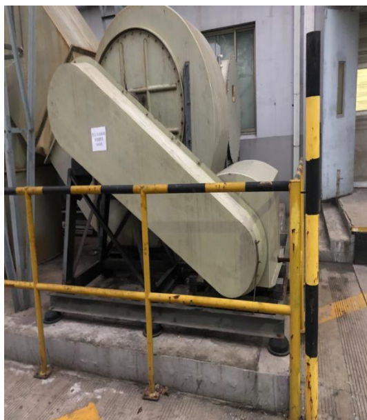
风机安装减震垫
